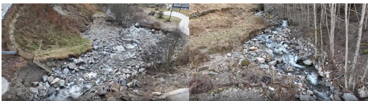
Figur 4: Bilder fra dronefilmen av situasjon etter Lathans tatt fra Thujordsvegen av Ringebu kommune. Det var steinkulvert med hvelvet tak her. Bekken sitt bunnsstrat er steinrik med endel blokker også. Nedstrøms Thujordsvegen til venstre og oppstrøms til høyre.
