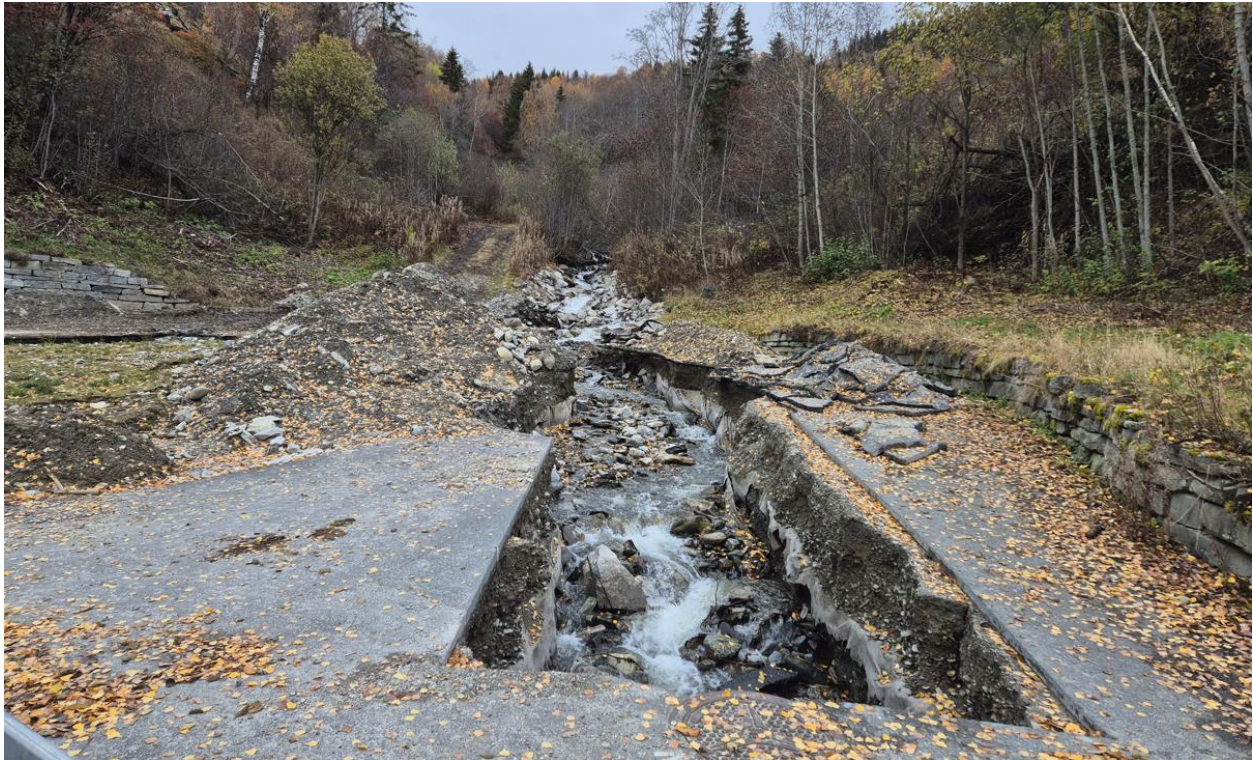
Figur 2: Snuplassen for busser ved fylkesveien, slik den så ut på befaringdagen (Foto: Jaran Wasrud/NVE 16.10.2024)
