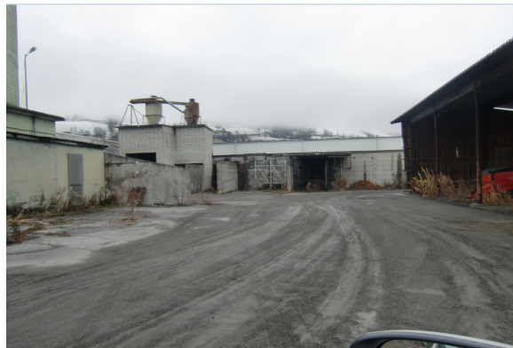
Inntrykk fra den sentrale delen av det nedlagte sagbruket
