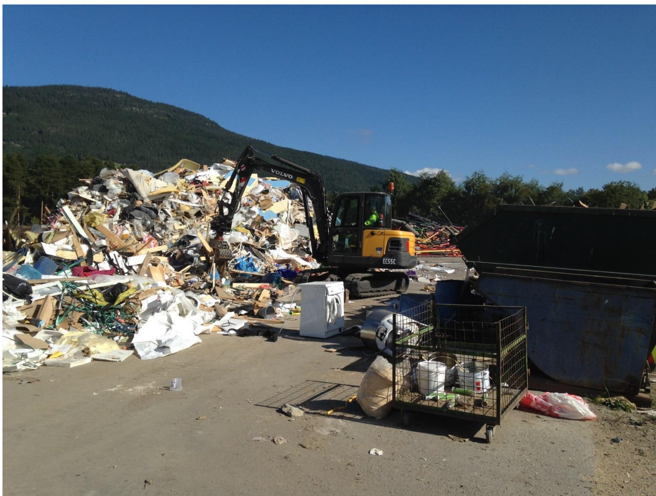
Sortering av restavfall/bygge- og rivningsavfall ved Frya miljøstasjon.
